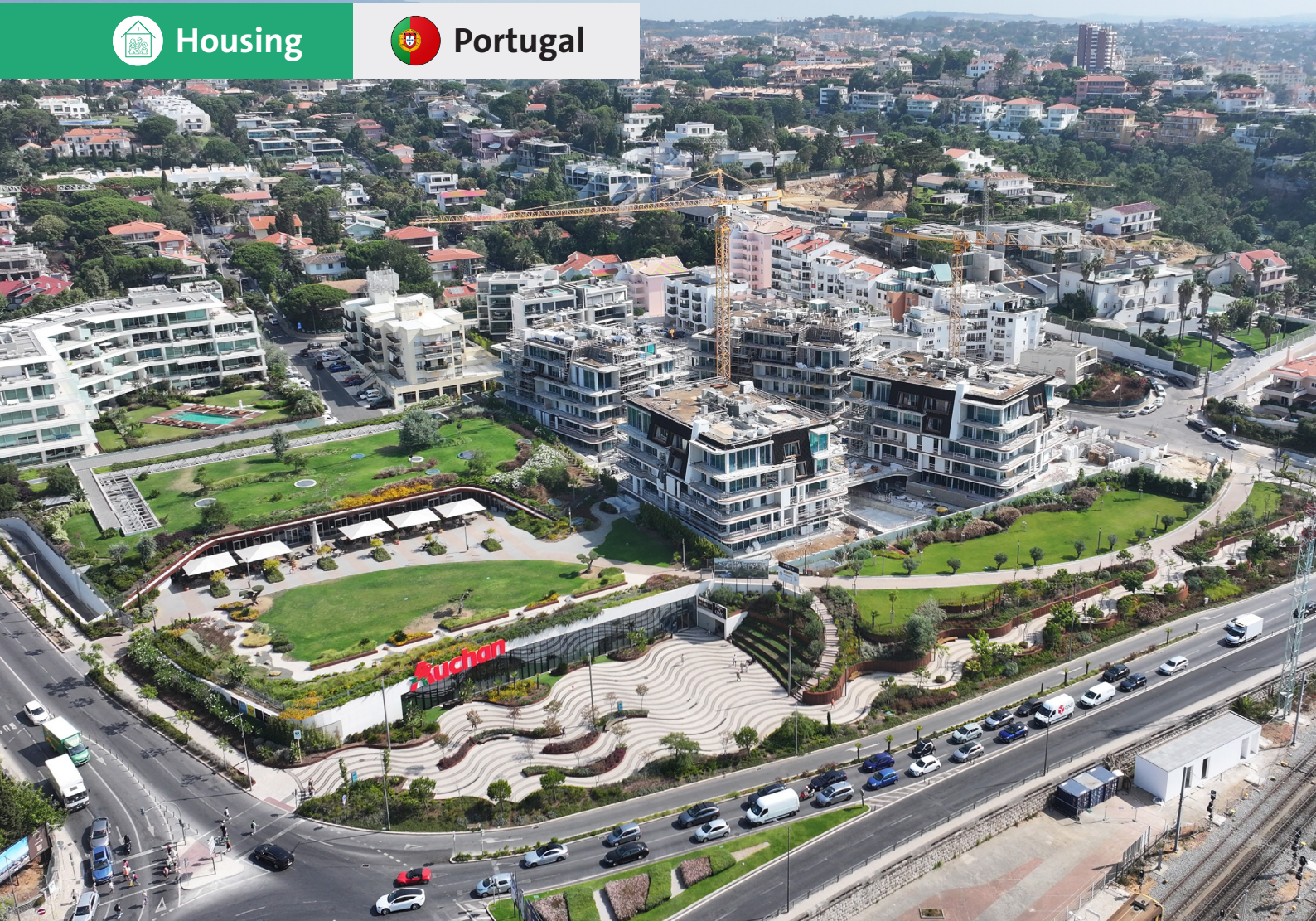
Project completed. Image courtesy of Teixeira Duarte, Engenharia e Construções SA.
